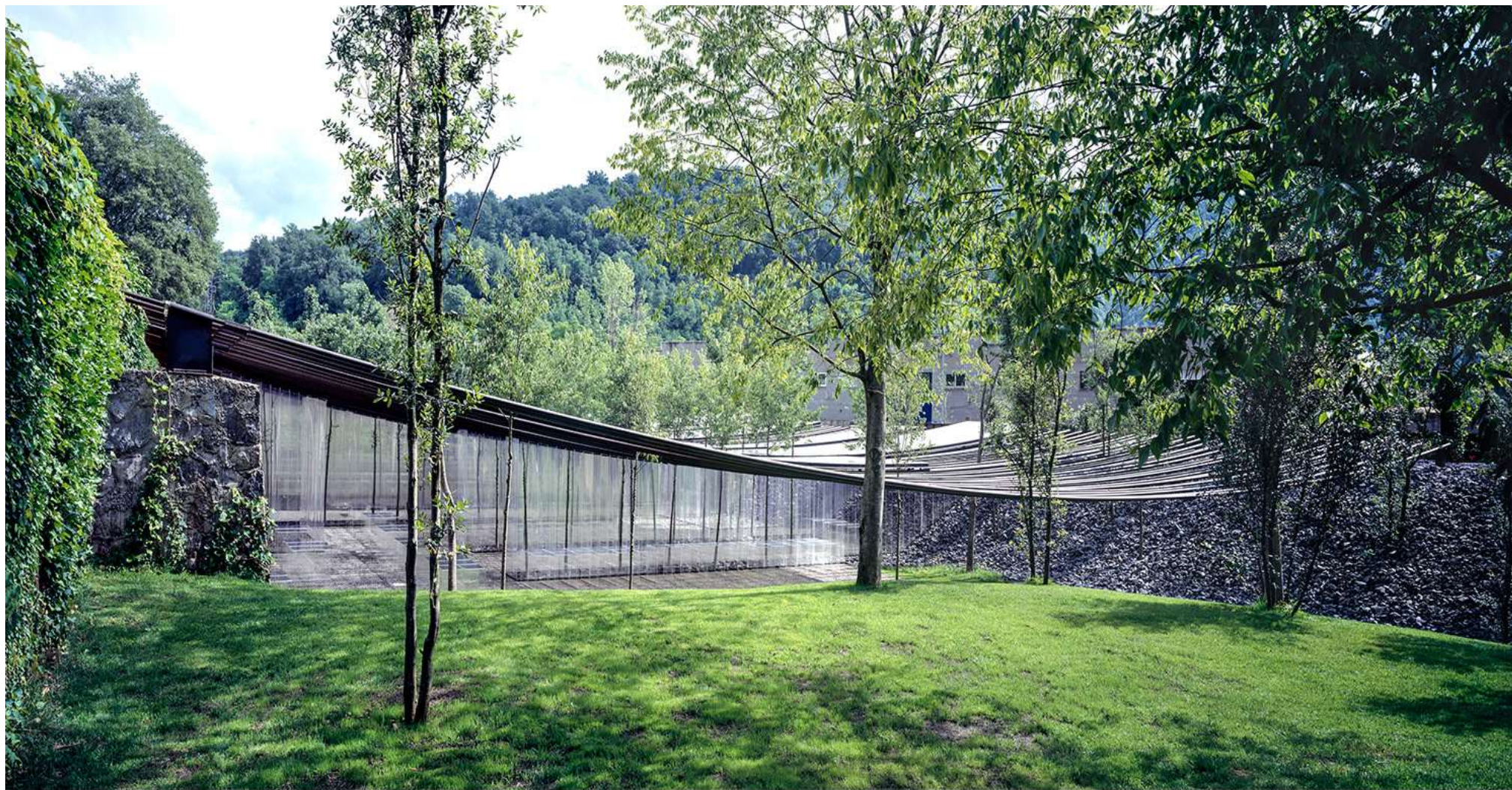
Les Cols, Olot – rcr architectes
