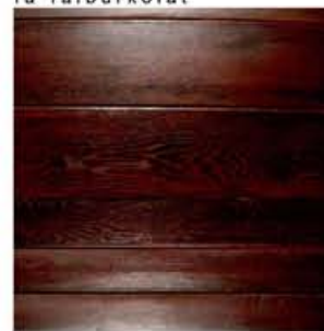
jelenlegi nagytermi fa faiburkolat
